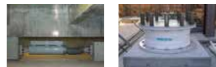
流体系ダンパー 錫プラグ入り積層ゴム支承
